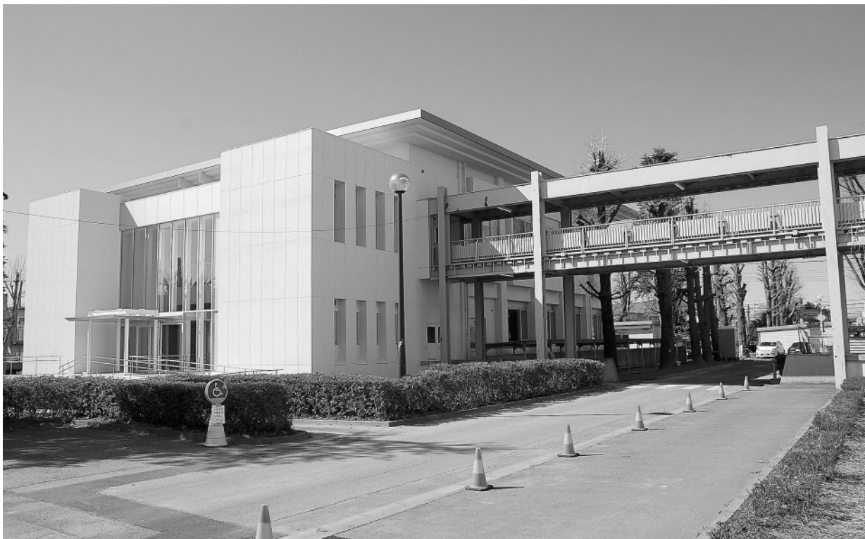
基礎講義棟 (改修工事後 平成26年3月)
